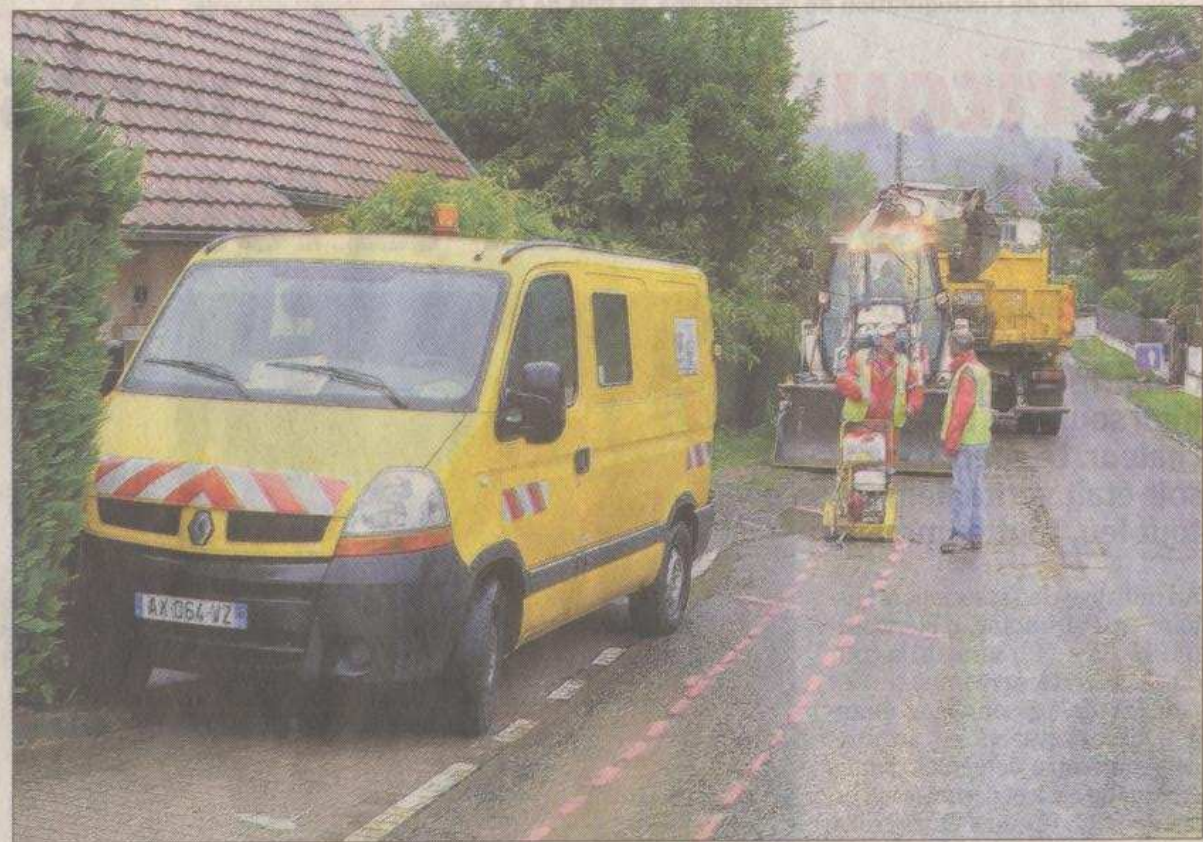
Sous peu, le nouveau lotissement sera raccordé au réseau électrique.
