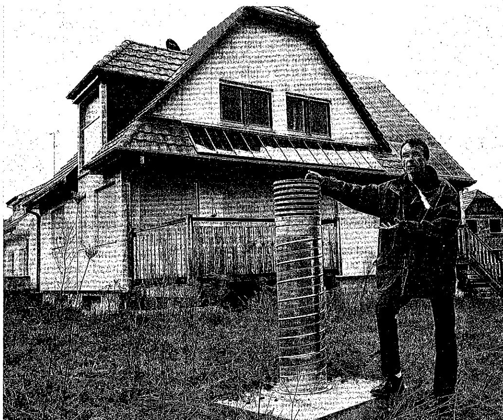
Michel Vandaele se tient à l'entrée d'air du puits canadien. Au fond, la maison qui réunit les dernières technologies en isolation, chauffage et récupération d'énergie. (Photo DNA-Christian Motsch)
