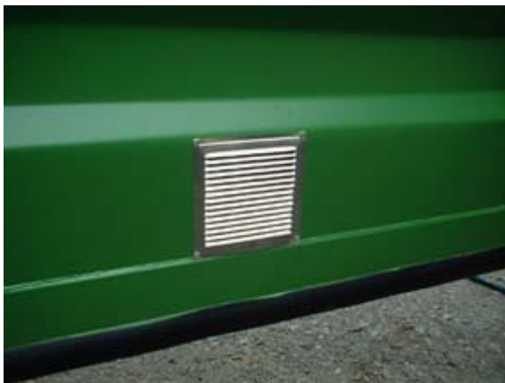
Ventilation statique basse
